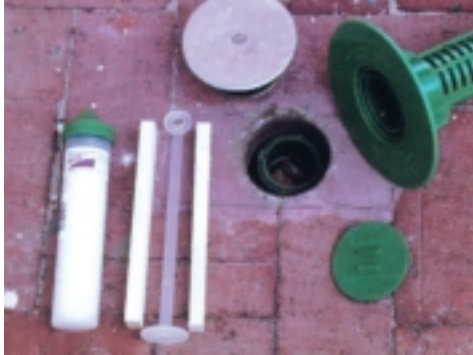
照片 8：正在露台下安装的诱饵装置。诱饵包含缓慢发挥药性的灭白蚁剂，白蚁将药剂搬回后，可灭除整个白蚁群。（图片来源：路易斯安那州立大学农业中心）
