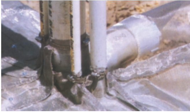
照片 3: 白蚁网是一项新近的研发成果，用于围住地基四周或防止白蚁通过管线孔进入建筑物。(照片来源: Termi-Mesh Florida LLC)
