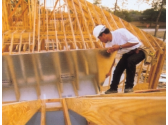
照片 7: 在某些情况下，采用经硼酸盐处理的木材产品建造房屋，是一种抑制白蚁的做法。（照片来源：Louisiana-Pacific® SmartGUARD™）
