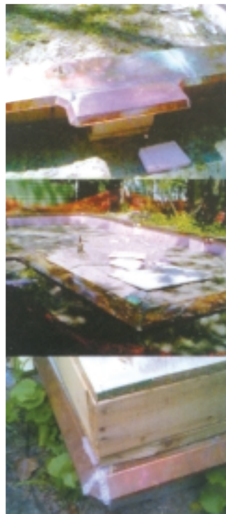
照片 4、5和 6: 白蚁挡板，即金属板屏障，安装在地基顶和地梁板之间。该屏障呈45度向下凸出于外部，迫使白蚁要绕着屏障构筑通道，因而较易被发现。(照片来源: 多伦多大学 Tim Myles)
