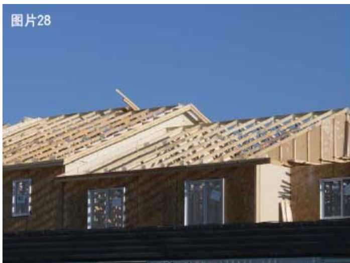
图片二十八 木桁架依靠优质木材和齿状金属片连接器为众多屋顶形状提供结构可靠性。J. 巴罗 (J. Burrows) 提供
