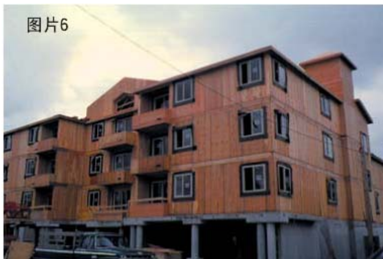
图片六 混合建筑物融合了混凝土和木结构的最佳性能。APA-工程木协会提供。
